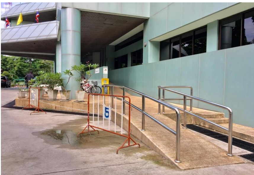
ทางลาดด้านข้างอาคาร
